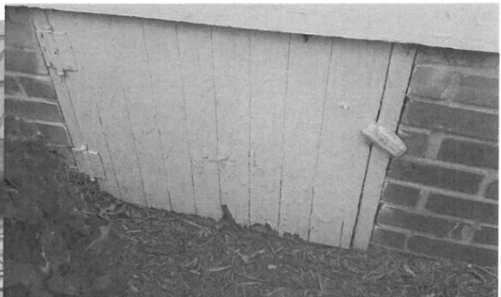
Crawl space door rotten wood
