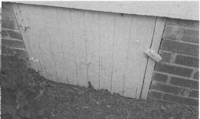
Crawl space door rotten wood
